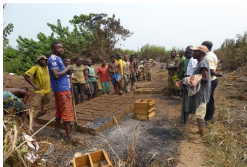
Le chantier de fabrication des briques
